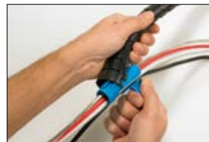
Placera appliceringsverktyget i ena änden av kabelskyddet Helawrap.
