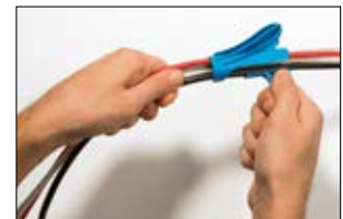
Lägg i en eller flera kablar i appliceringsverktyget.
